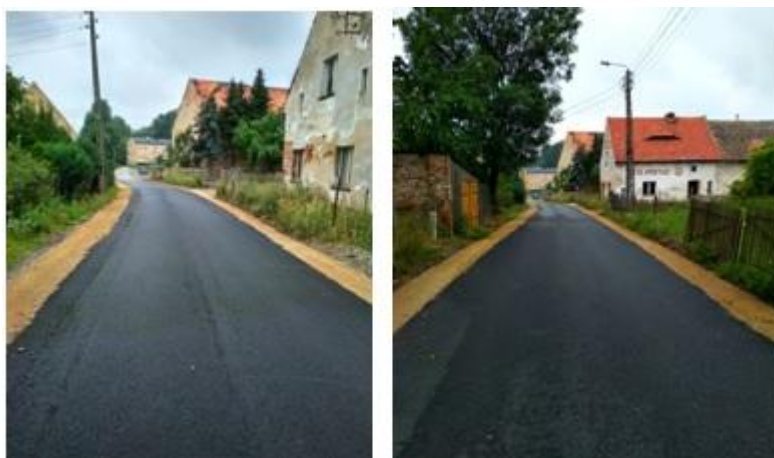
Zdjęcie: nowa nawierzchnia.
