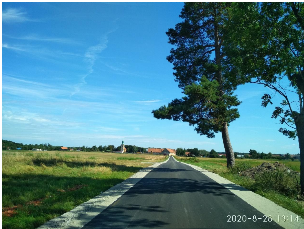
Zdjęcie: Położona warstwa ścieralna i uzupełnione pobocza
