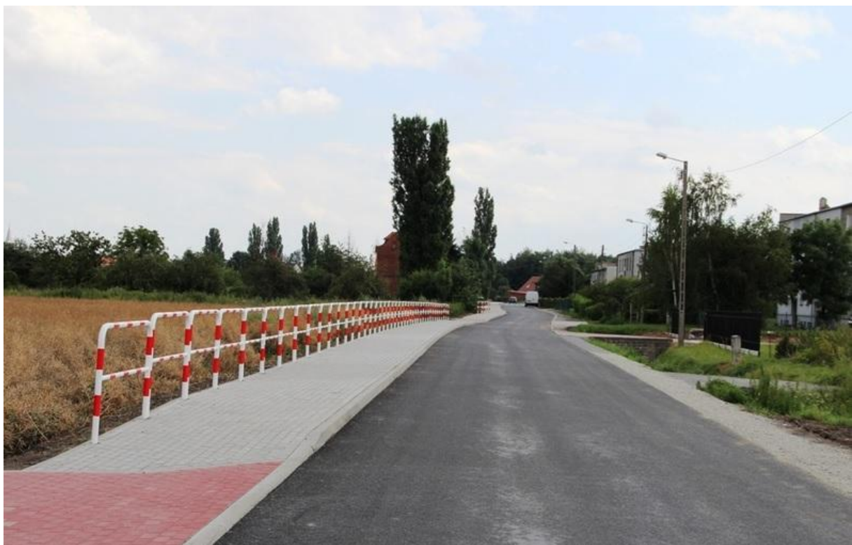
Zdjęcie: Droga w Piersnie po przebudowie
