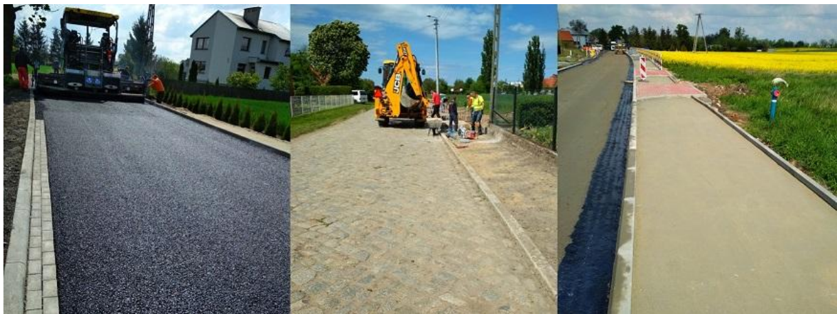
Zdjęcie: Droga w Piersnie w trakcie przebudowy
