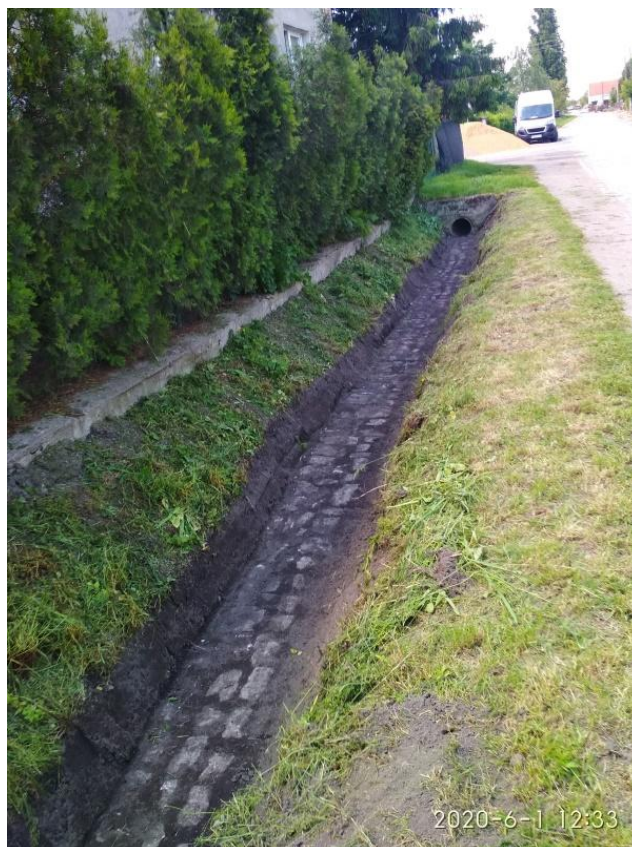
Zdjęcie: Wyregulowany istniejący krawężnik i wykonane korytowanie pod chodnik
