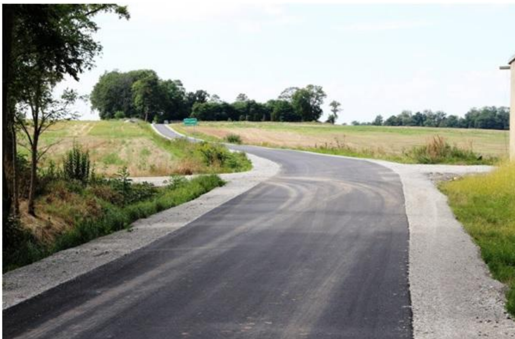
Zdjęcie: Odbiór drogi Chmielów – Wnorów
