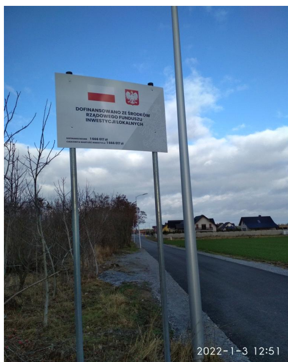
Zdjęcie: Przebudowa ul. Sportowej Kostomłoty
