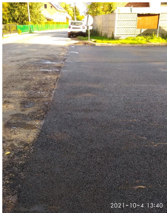
Zdjęcie: Przebudowa drogi Ramultowice
