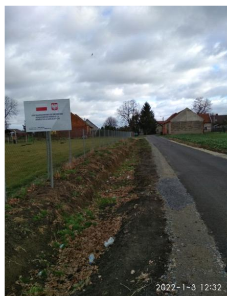
Zdjęcie: Remont drogi Sobkowice wykonanie profilowania istniejącej nawierzchni i nowa warstwa jezdni
