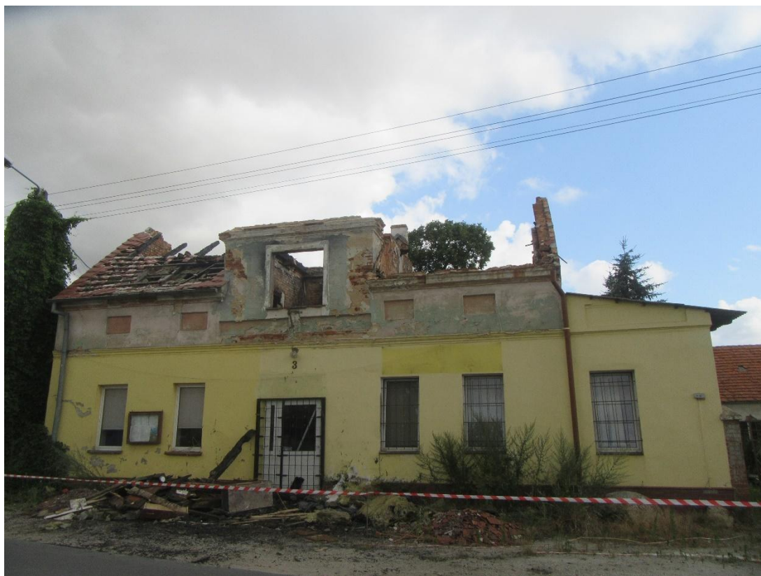
Zdjęcie: Odbudowa świetlicy wiejskiej w miejscowości Bogdanów (przed i w trakcie)
