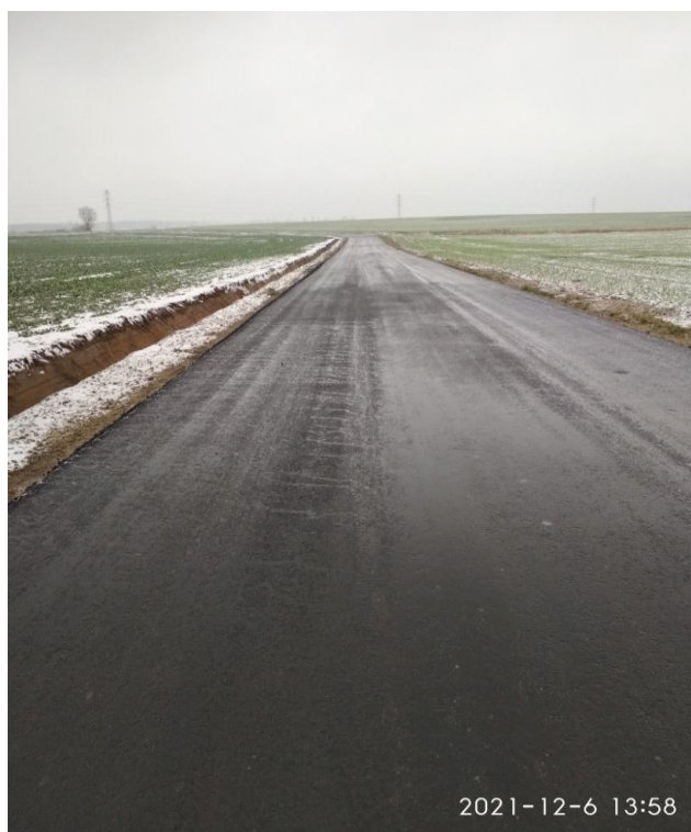
Zdjęcie: Nawierzchnia z betonu asfaltowego i rów odwadniający na drodze Świdnica Polska-Sikorzyce
