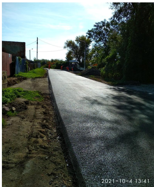
Zdjęcie: Przebudowa drogi Ramultowice
