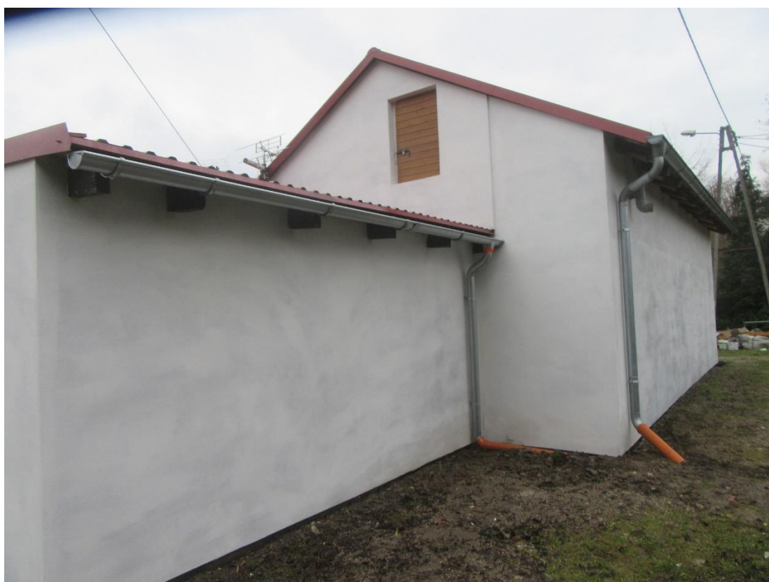
Zdjęcie: Modernizacja świetlicy wiejskiej w miejscowości Paździorno (przed i po)
