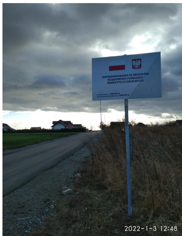
Zdjęcie: Przebudowa ul. Sportowej Kostomłoty
