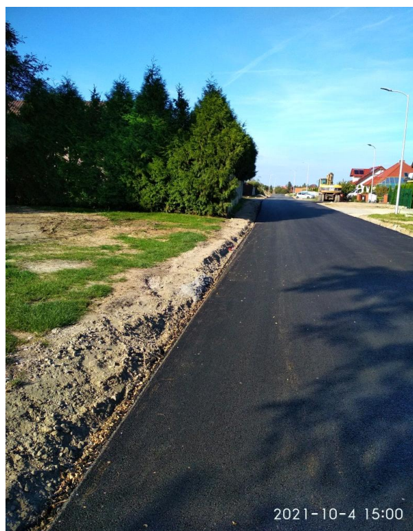
Zdjęcie: Przebudowa ul. Sportowej Kostomłoty
