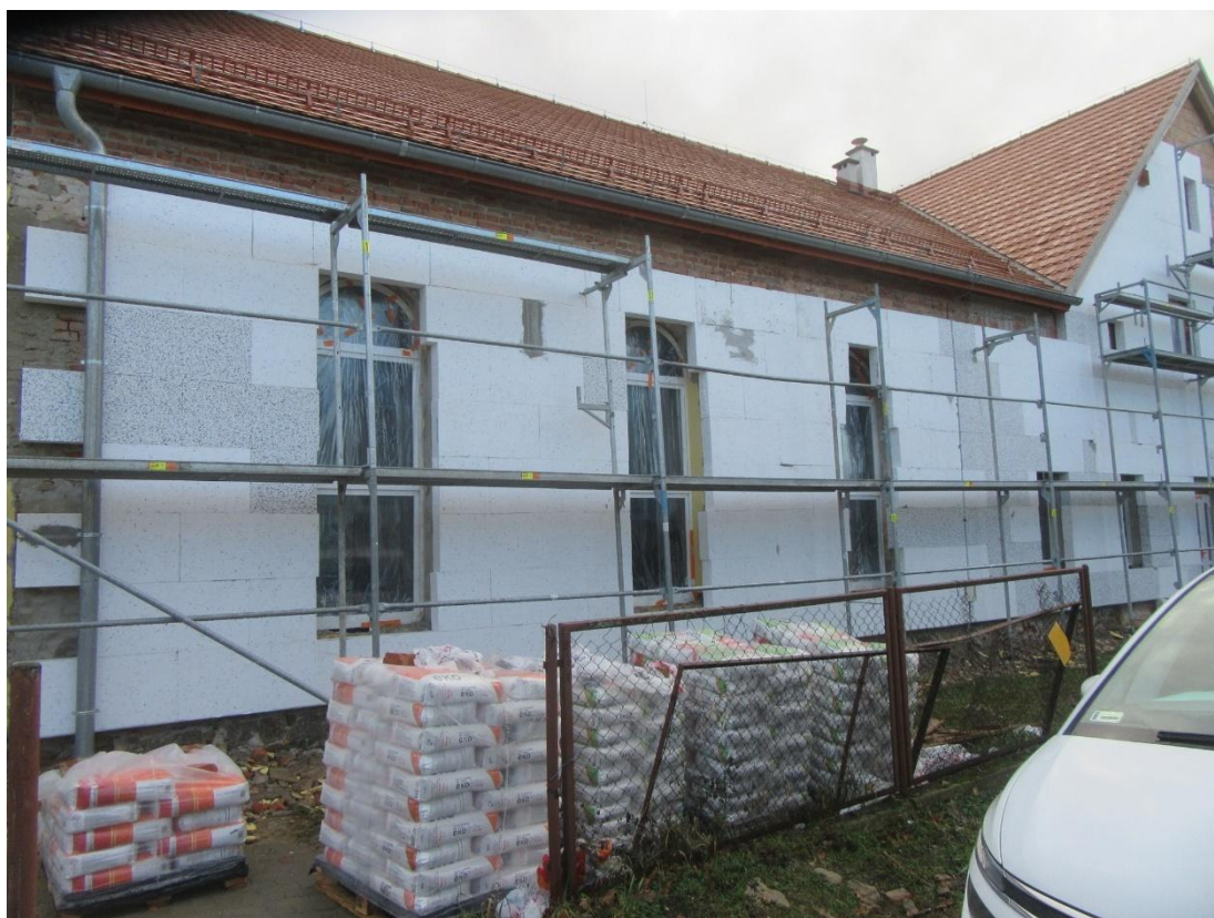
Zdjęcie: Remont świetlicy w Jarząbkowicach (przed i po)
