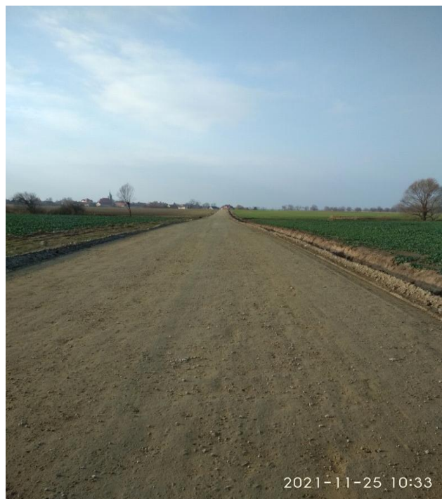
Zdjęcie: Przebudowa drogi Świdnica Polska-Sikorzyce
