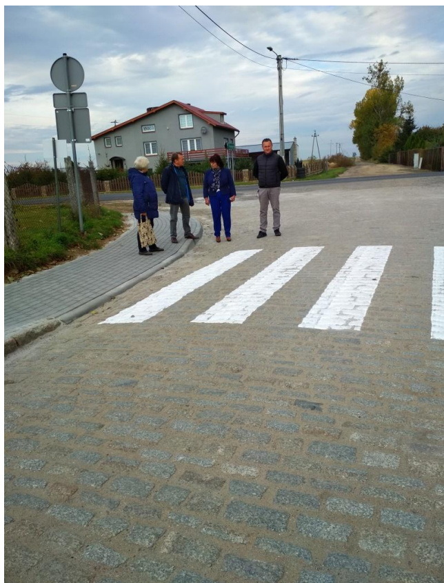
Zdjęcie: Przebudowa chodnika Budziszów
