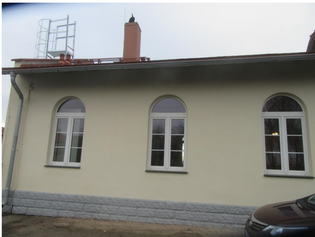
Zdjęcie: Remont pokrycia dachowego świetlicy w Zabłociu (przed i po)
