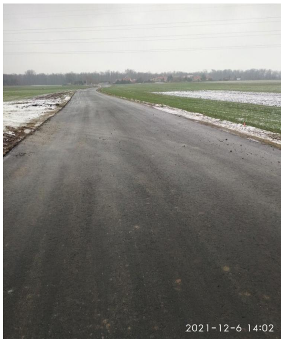
Zdjęcie: Wykonana podbudowa na drodze Świdnica Polska-Sikorzyce
