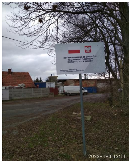
Zdjęcie: Przebudowa drogi Ramułtowie
