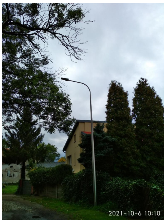
Zdjęcie: zamontowane oprawy oświetleniowe w Wichrów
