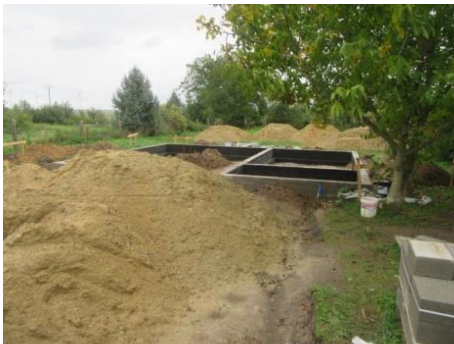
Realizacja obiektu – ściany fundamentowe
