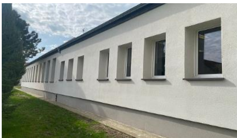
Zdjęcia: Szkoła Podstawowa w Mieczkowie – sala gimnastyczna w trakcie i po ociepleniu oraz docieplony budynek szkolny
