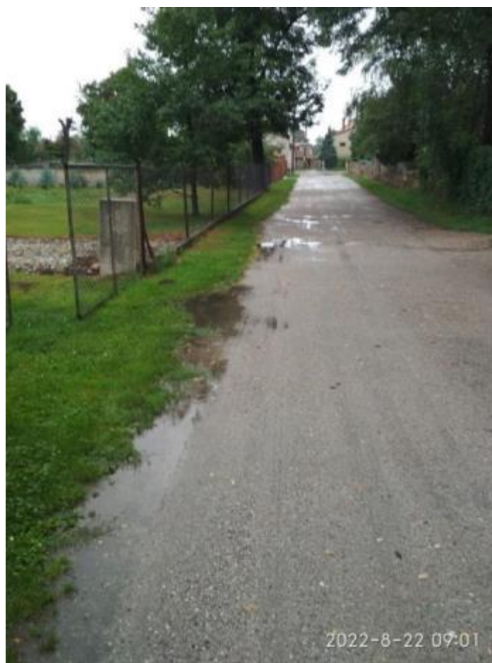
Zdjęcie: droga w miejscowości Piersno przed przebudową
