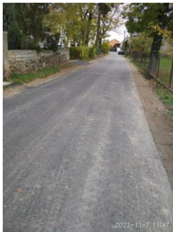
Zdjęcie: droga w miejscowości Piersno po przebudowie
