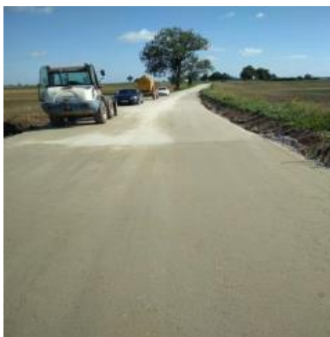
Zdjęcie: wykonana podbudowa na poszerzeniu i całej szerokości drogi
