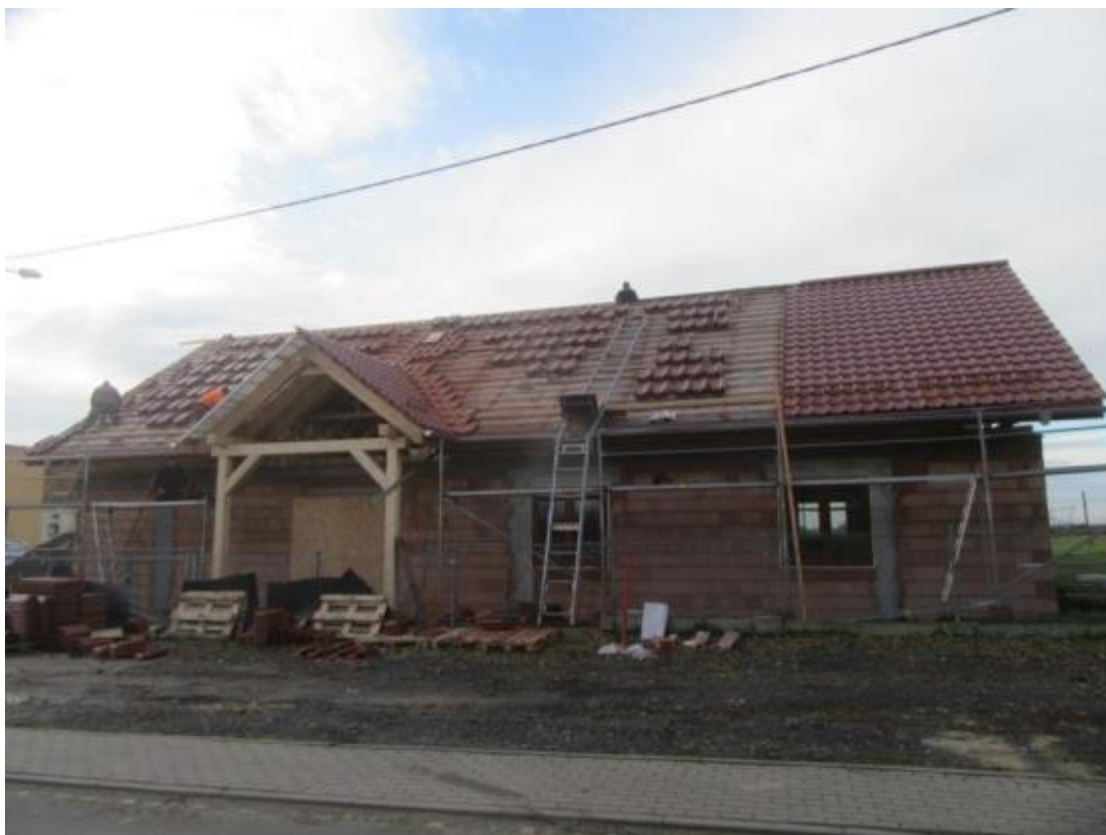
Realizacja pokrycia dachowego
