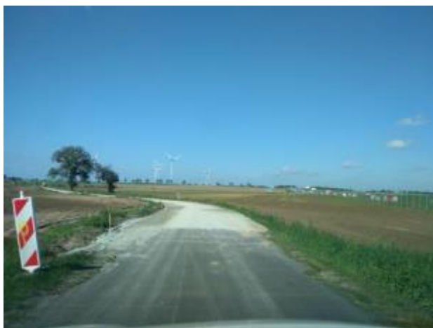
Zdjęcie: wykonana podbudowa na poszerzeniu i całej szerokości drogi
