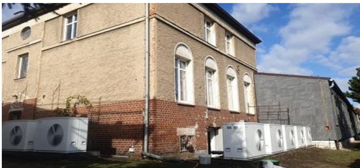
Zdjęcie: Szkoła Podstawowa w Mieczkowie – prace termomodernizacyjne i zamontowane pompy ciepła
