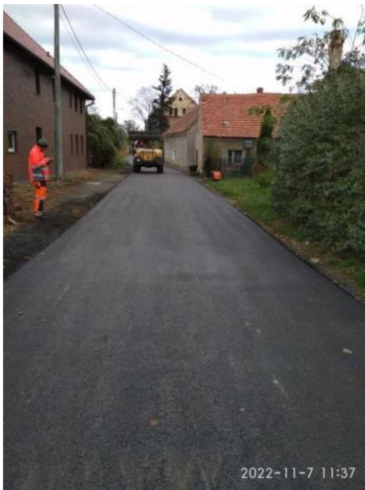
Zdjęcia: Zabłoto - droga po wykonanej przebudowie
