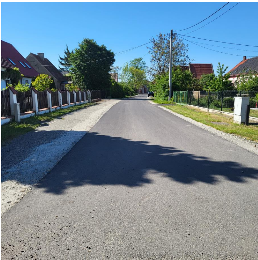
Zdjęcia: Przebudowana droga w miejscowości Wilków Średzi
