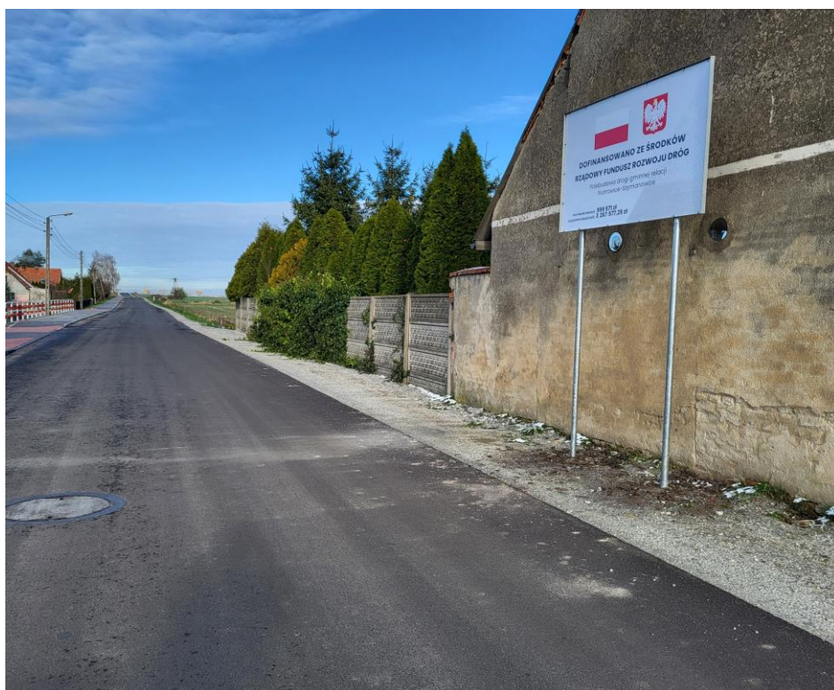
Zdjęcia: budowa drogi gminnej relacji Piotrowice Szymanowice
