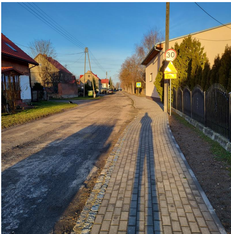
Zdjęcie: przebudowa chodnika w miejscowości Osiek
