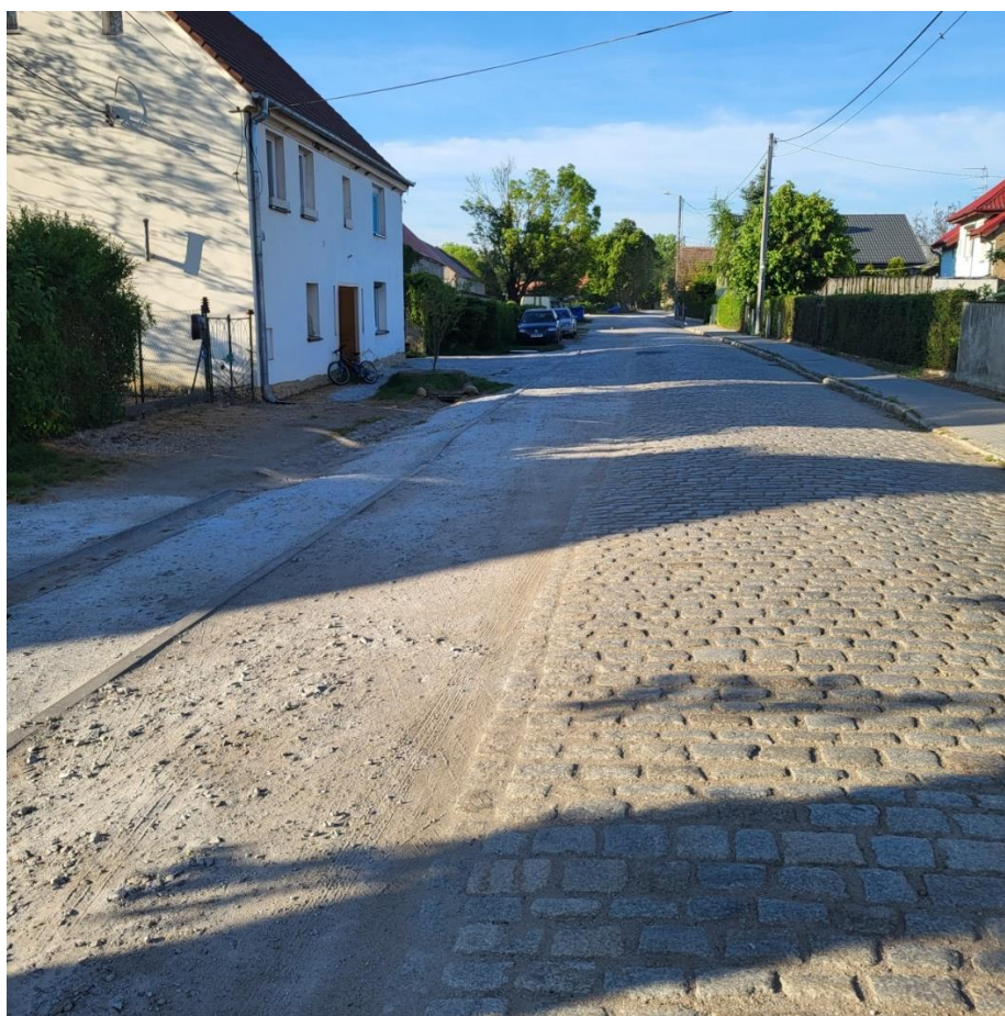
Zdjęcie: przebudowa pobocza Budziszów
