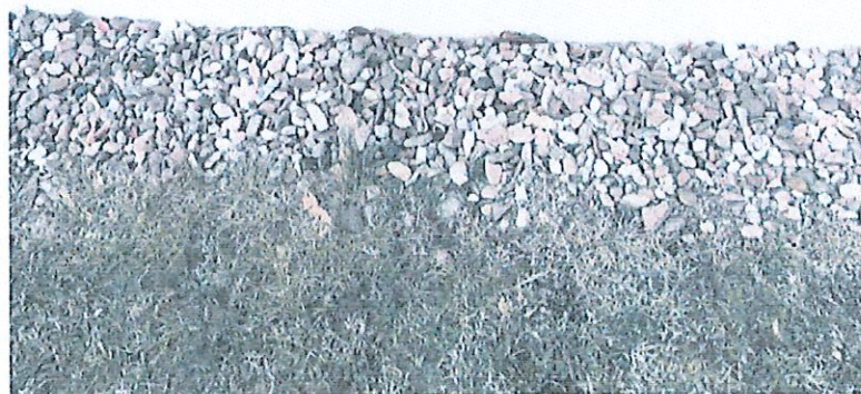
Fasada południowa, drenaż wokół muru
