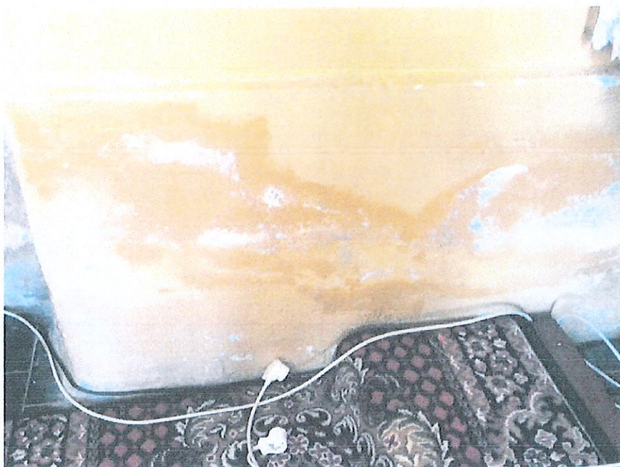
Nawa, ściana północna, wysolenia na wysokości brudnika
