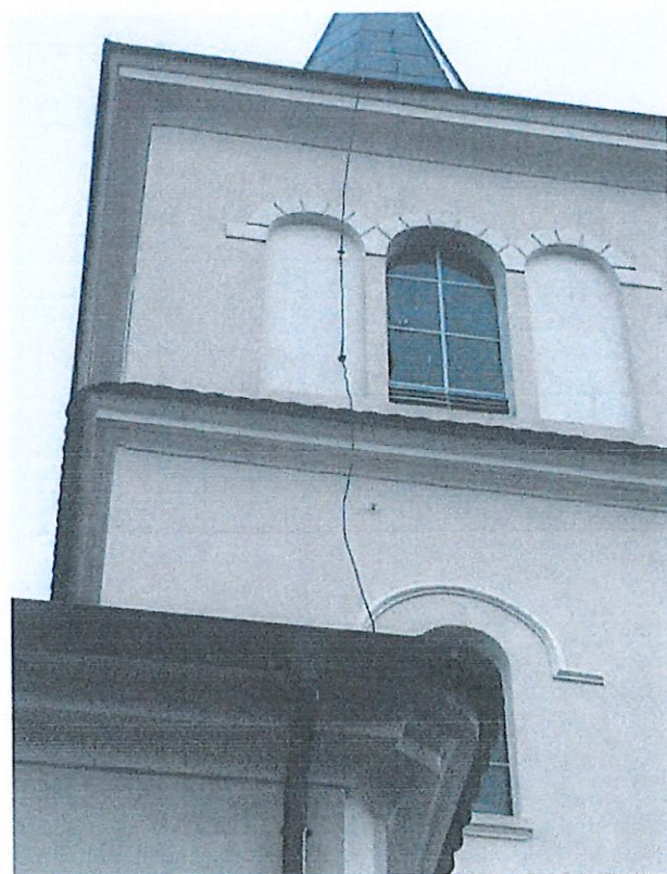
Fasada północna, widok na wieżę, (widoczna nowa instalacja odgromowa)
