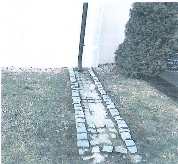
Fasada południowa, nowe rury spustowe, koryta odprowadzające deszczówkę
