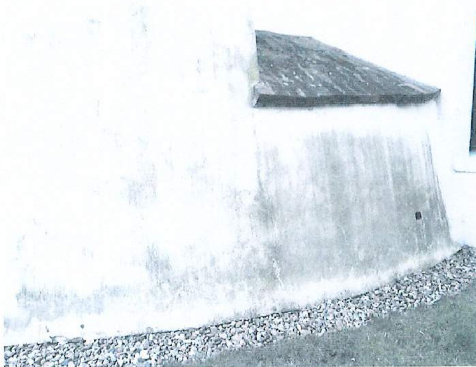
Fasada północna, część wschodnia, widoczne ślady glonów, nowy drenaż wokół murów
