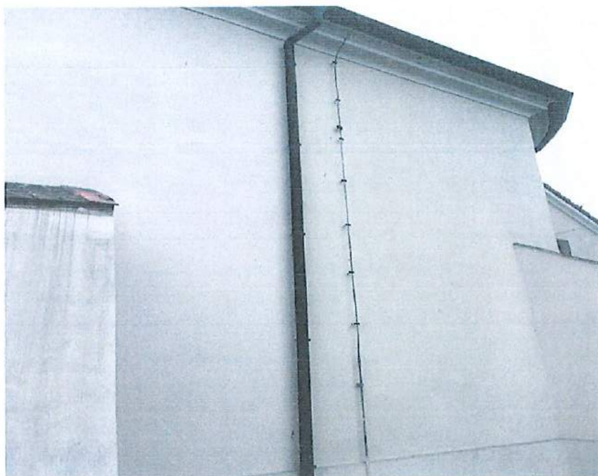
Fasada północna, instalacja odgromowa
