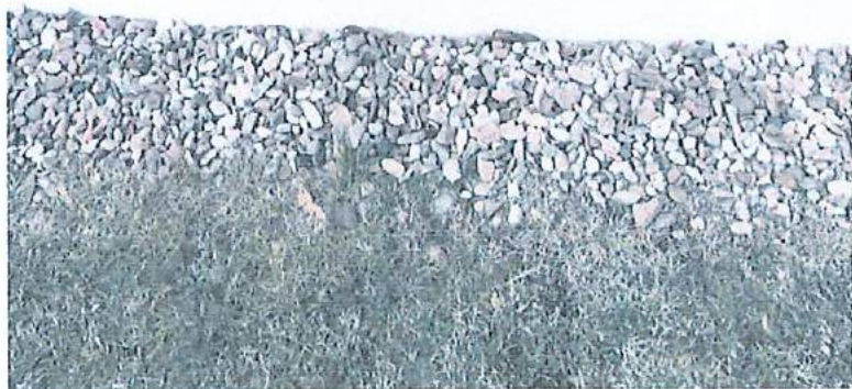
Fasada południowa, drenaż wokół muru
