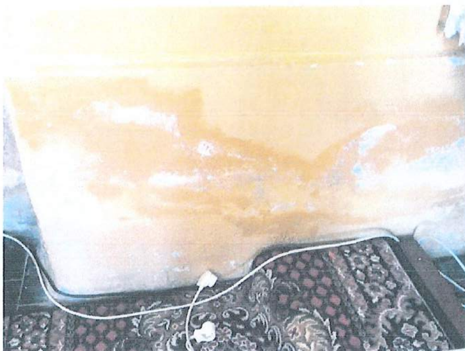
Nawa, ściana północna, wysolenia na wysokości brudnika
